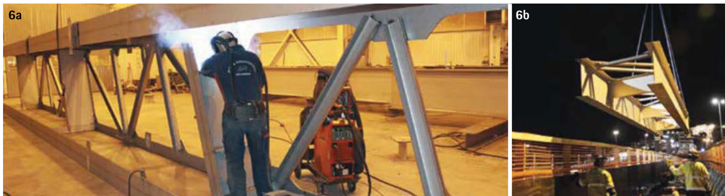
Fig. 6 - Travi del ponte ferroviario di Stoccolma in corso di fabbricazione (a) e in fase di installazione (b) (Courtesy: Lars Hamrebjörk)
