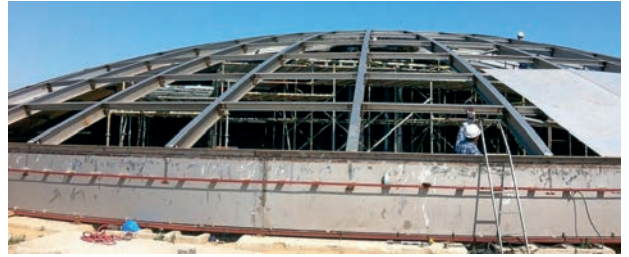
Figura 3. Seções de aço inoxidável estrutural utilizadas na cobertura em cúpula de uma instalação industrial de armazenamento de adubo e nitrato na Polónia
