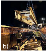
Figura 4. Fabricação (a) e instalação (b) de vigas em aço inoxidável a utilizar numa ponte ferroviária em Estocolmo
