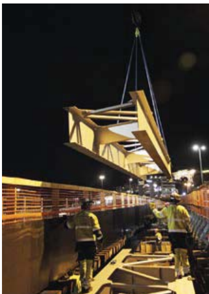
På natten under ett trafikstopp lyfts sektionerna på plats.
