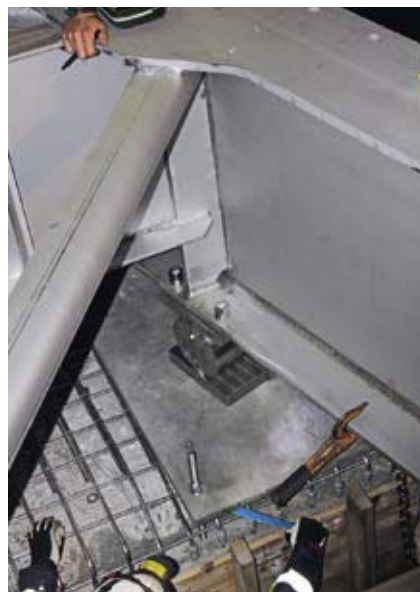
Sedan återstår det finjustering och därefter ska sektionerna svetsas samman.
