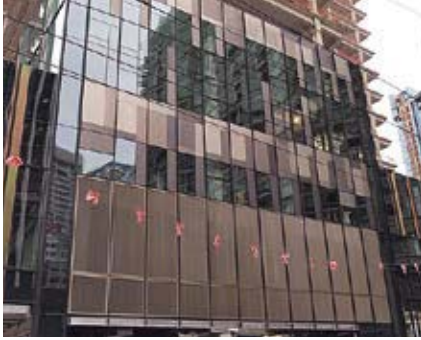
Bild 2: Utbudet av mönstervalvade och slipade ytor är stort. Goda möjligheter finns att anpassa bl.a. materialets reflektionsförmåga.
