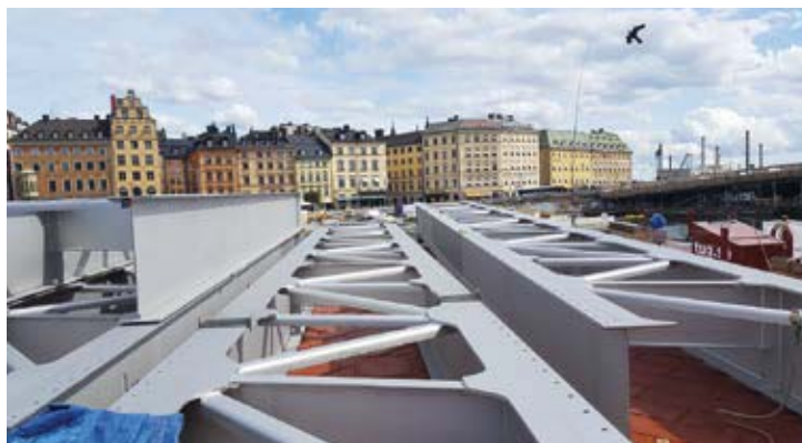
Brosektionerna ligger här på en pråm vid Gamla Stan i väntan på monteringen.
