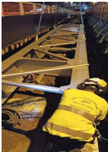
Stål & Rörmontages monterer ser till att sektionerna kommer exakt på plats.
